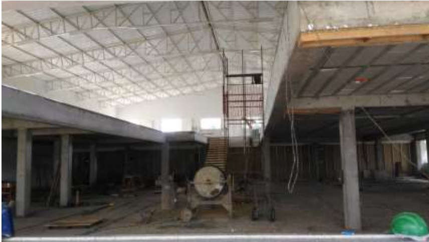
Unidade BR – Ampliação
